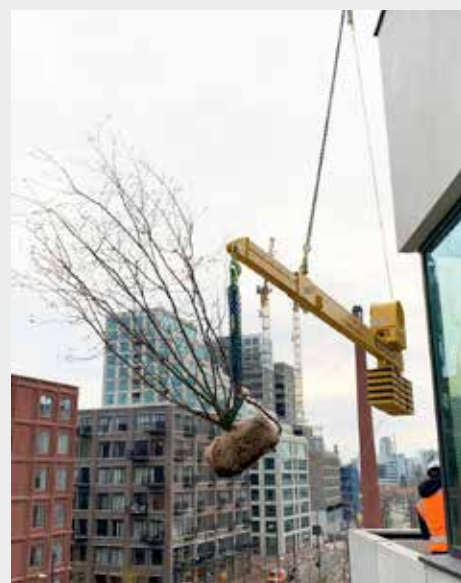
▲ Výsadba stromů pomocí jeřábu s vahadlem
